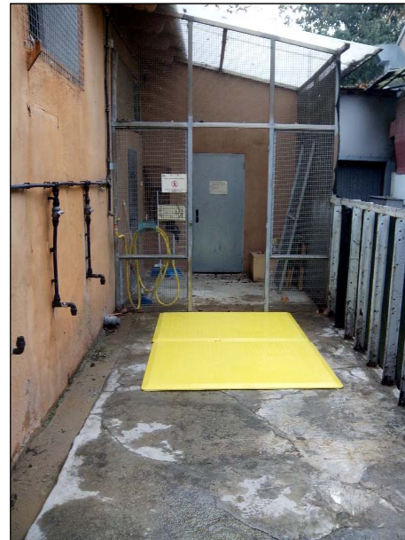
FOTO 8. Vista de l'estat del lloc un cop finalitzada la intervenció.
