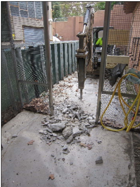
FOTO 3. Detall dels treballs de picat i retirada del paviment de formigó.
