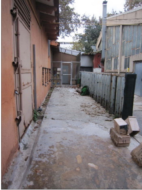
FOTO 1. Vista general del passadís d'accés a l'edifici de quarantena (edifici taronja).
